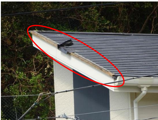
写真 22. 化粧スレート屋根。築年数の浅い物件。ケラバ板金が飛散している。見たことがない被害。
