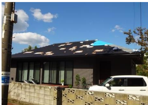
写真 2. 瓦屋根 (F 形瓦) 飛来物による被害
