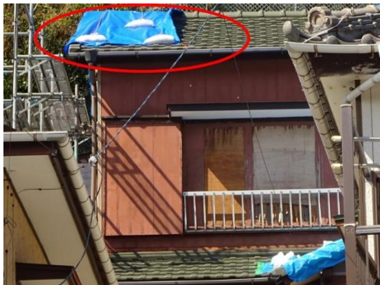
写真 46. 瓦屋根（F形瓦・非防災タイプ）には被害が見られた。（築年数が20～30年なので防災タイプではない。）
