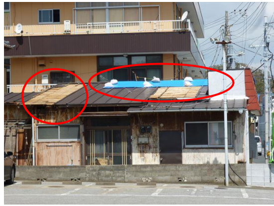
写真 33. 金属屋根（瓦棒葺き）。平部、棟部が飛散。
