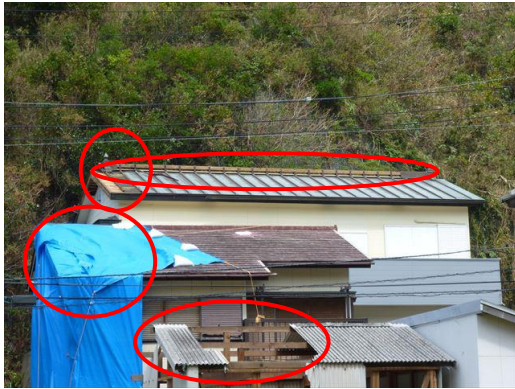
写真 30. 金属屋根（瓦棒葺き）。ケラバ・平部・棟包みが飛散。その下の化粧スレート屋根も同様。
