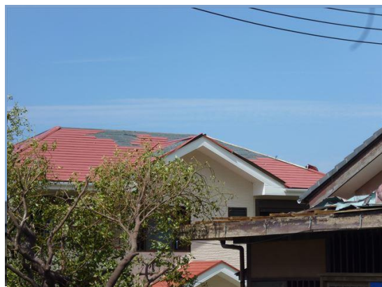
写真 37. 化粧スレート屋根の再塗装。平部・棟部が飛散。
