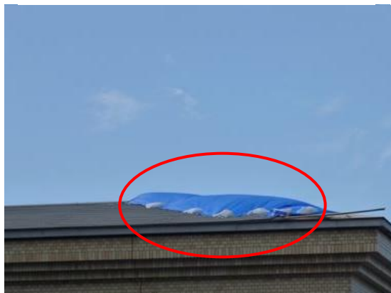
写真 35. 金属屋根（横葺き）。平部・棟部が飛散。
