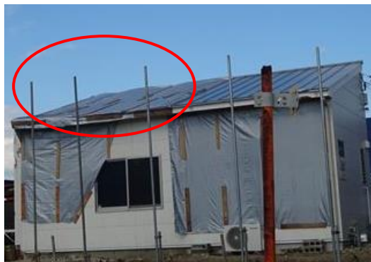
写真 28. 金属屋根（立平葺き・ガルバリウム鋼板）。ケラバ・平部・棟包みが飛散。
