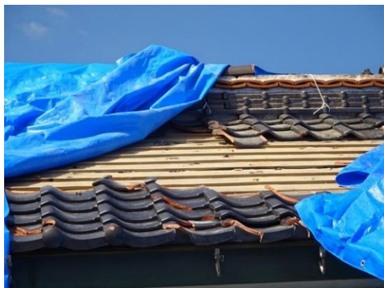
写真 16. 瓦屋根 (J 形瓦)。平部の棧瓦が飛散。くぎ打ちなし。棟部も冠瓦が飛散。
