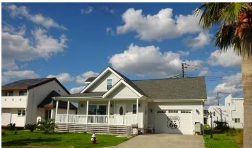
写真 51. アスファルトシングル葺き（右）天然スレート葺き（左）被害なし。
