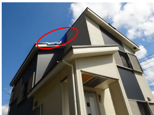
写真 23. 21 と同じ建物。片流れ棟包み板金も飛散。
