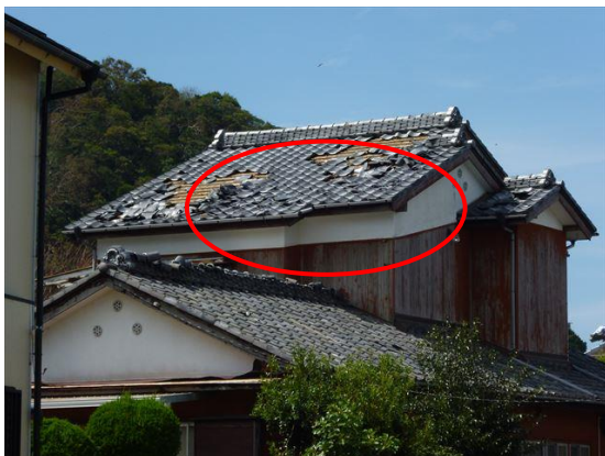
写真 32. 瓦屋根（J形瓦）。平部が飛散。くぎ打ちなし。棟部は飛散なし。
