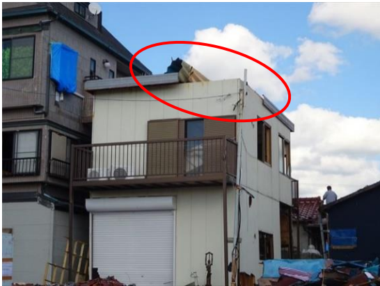
写真 44. 金属屋根（折半葺き）が半分めくりあがっている。
