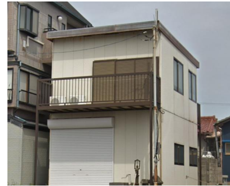
(金属屋根・折板葺き)
