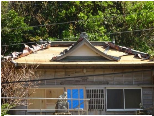
写真 26. 金属屋根（銅板葺き）。浅間神社。銅板の平部が飛散。
