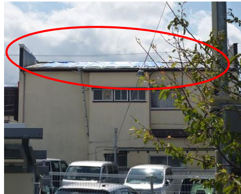
写真 31. 三方パラペット・金属屋根（瓦棒葺き）。平部、パラペット笠木が飛散。
