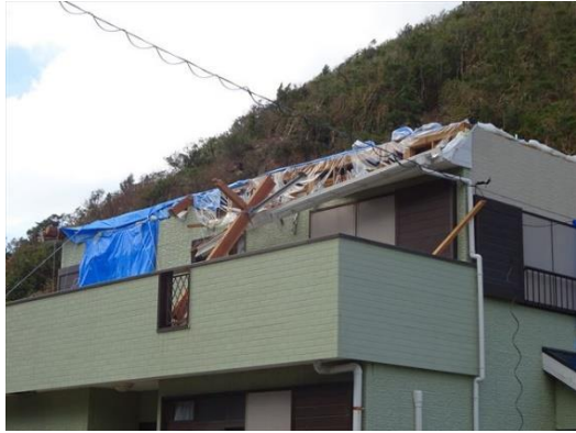
写真 24. 化粧スレート屋根。屋根下地・小屋組みが飛散。
