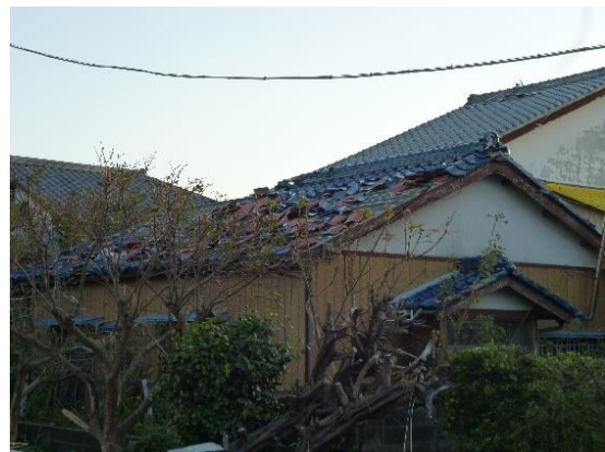
写真 47. 瓦屋根（J形瓦）は平部被害あり。くぎ留めされていない。
