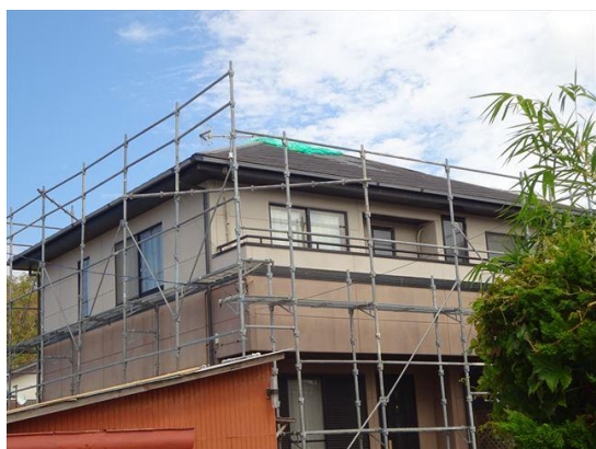
写真 12. 化粧スレート屋根の頂部に養生シート設置。
