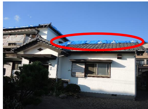
写真8. 瓦屋根 (J形瓦) の棟部の被害
