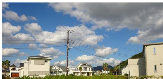
写真 52. 全体風景。海岸付近で、密集していない立地。太陽光設置屋根も被害なし。
