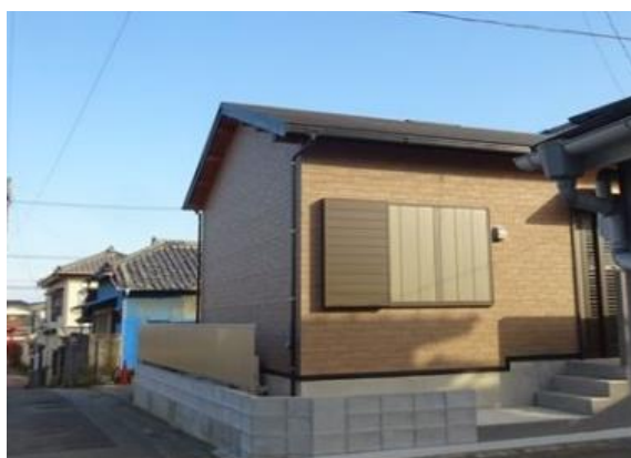
写真 4. 化粧スレート屋根 (平家) 被害なし
