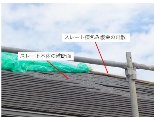
写真 13. スレート本体の破断面の様子。くぎ抜けは発生していない。
