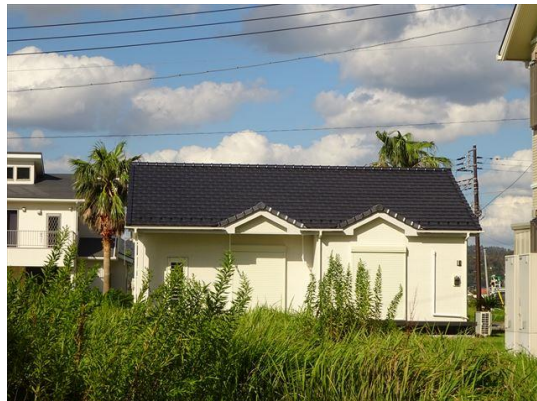
写真 50. 瓦屋根（F形瓦・防災タイプ）被害なし。
