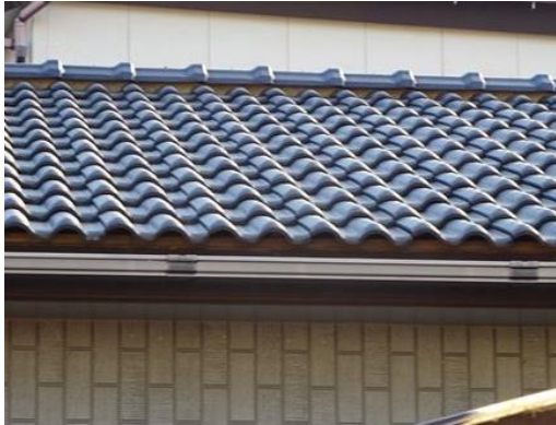
写真5. 瓦屋根 (F形瓦・防災タイプ) の被害なし (ガイドライン準拠)
