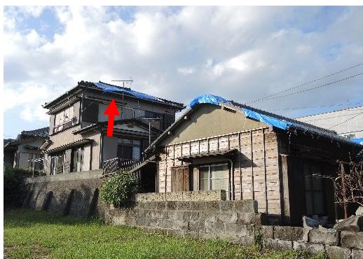
写真9. 瓦屋根 (J形瓦) の棟部・平部の被害
