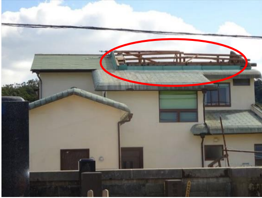
写真 42. 金属屋根（銅板葺き）。屋根下地（野地板・たる木）ごと飛散。
