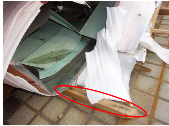
写真 43. 飛散したたる木には、結露痕が見られた。
