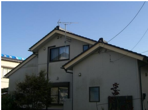
写真7. 瓦屋根 (J形瓦・防災タイプ) の被害なし (ガイドライン準拠)
