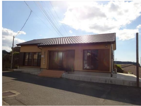
写真 45. 道路を挟んだ反対側の瓦屋根（F形瓦・防災タイプ）は被害なし。
