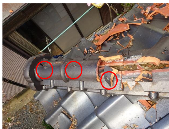
写真 17. 瓦屋根 (J 形瓦)。棟部の冠瓦は下から銅線で留め付け。2 階の屋根から飛散した瓦による破損。
