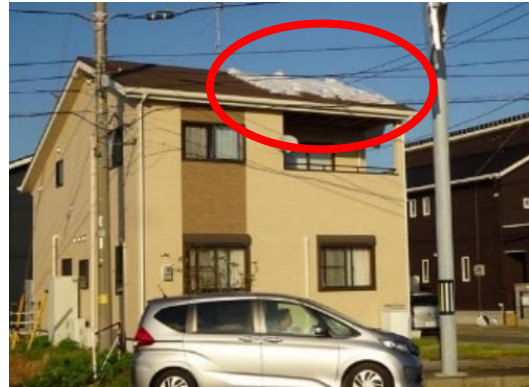
写真6. 化粧スレート屋根の棟部・平部の被害
