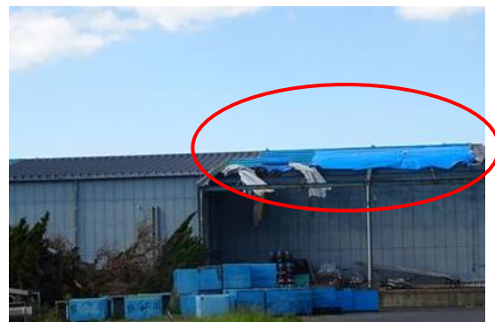
写真 29. 金属屋根（折半葺き）。工場・倉庫の金属屋根も飛散。
