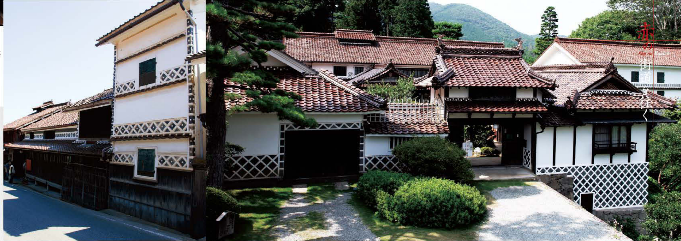
【西江邸】江戸時代中期の家屋を代々の当主が守り継承している
