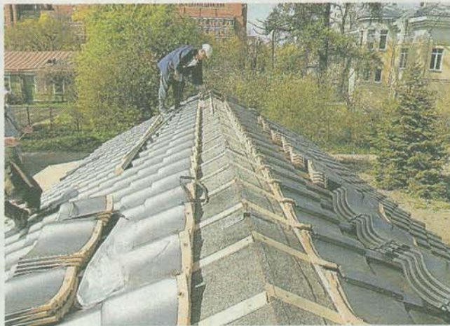
ロシア・サンクトペテルブルク市内の茶室の屋根に施工される石州瓦。石州瓦は海を渡り、ロシア市場で本格的に動きだそうとしている
