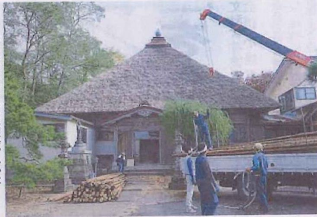
解体作業が始まった松源寺。かやぶきの本堂は県内でも珍しいという
