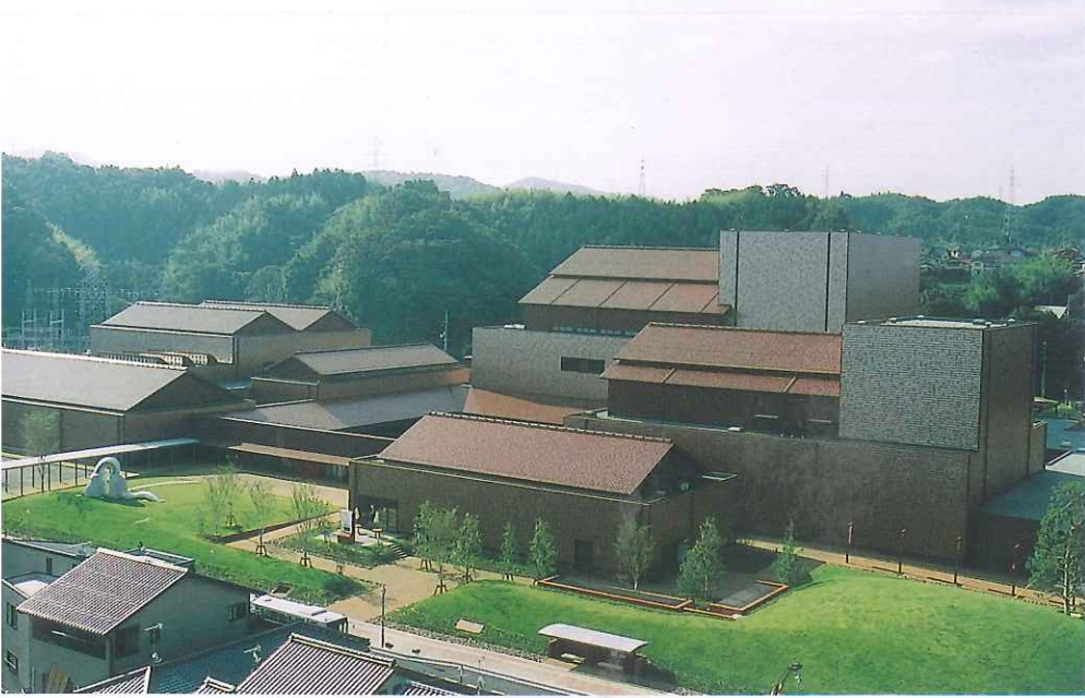
芸文センターの全景
