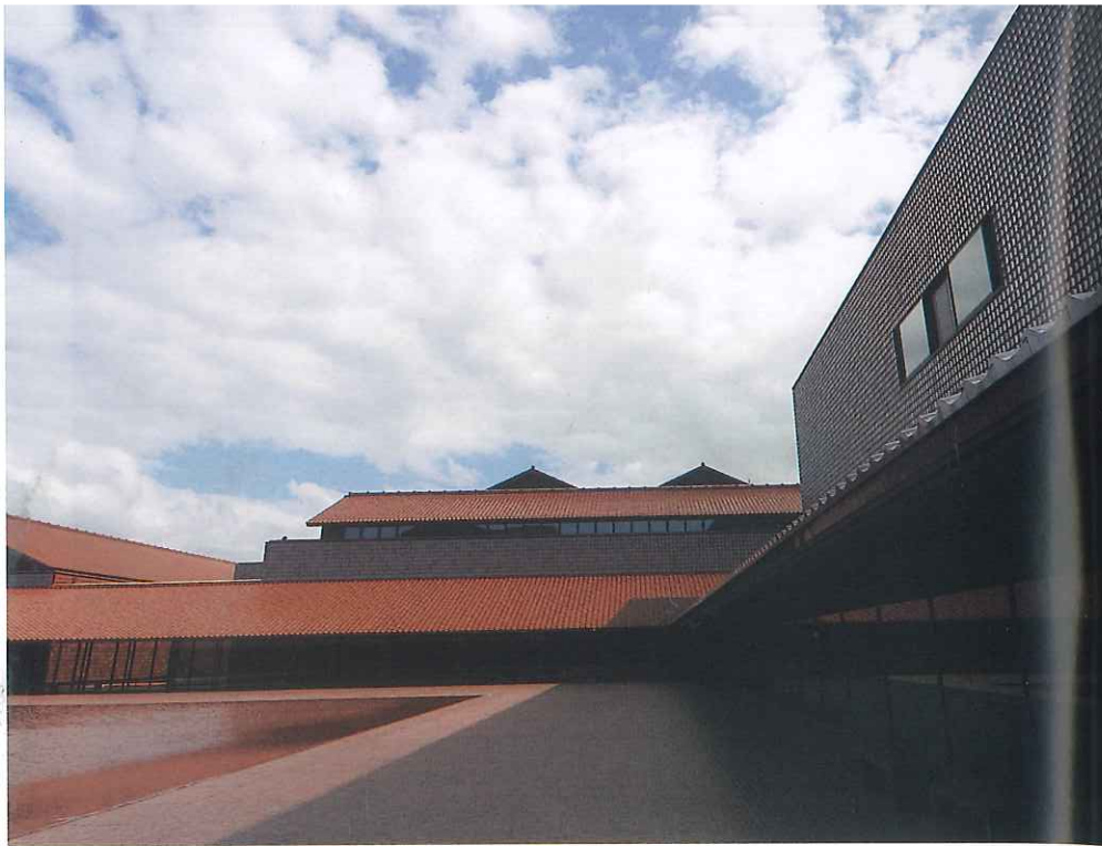
瓦で覆われた芸文センター。中庭にその求心力を持たせた 写真提供・高根県芸術文化センター
