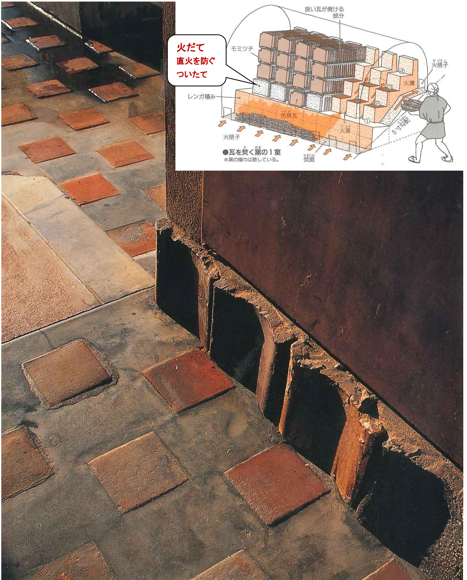
▲島根県・江津市庁舎【設計：吉阪隆正氏+U研究室】の2階玄関 1962年（昭和32年）の竣工当時、石州瓦産地の登り窯な中で使われていた「 製品への直火を防ぐためのついたて（火だて） 」、「 床の敷瓦ちらし貼り 」
