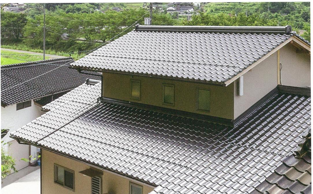
銀黒色の石州瓦を使用したO様邸。棟の直線と波打つような瓦の曲線が美しい。この家で約3000枚の石州瓦が使用されている。
