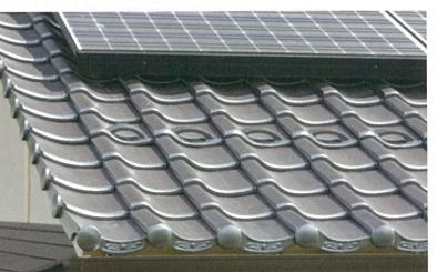
瓦同士が互いにしっかりと組み合って、屋根に固定されているので風速40mの台風にも耐えられる設計。国内最高品質と呼ばれる所以だ。
