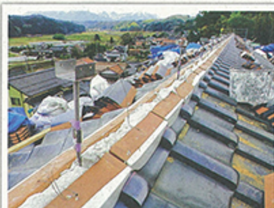
「ガイドライン工法」で屋根の施工が進む住宅工事の現場
