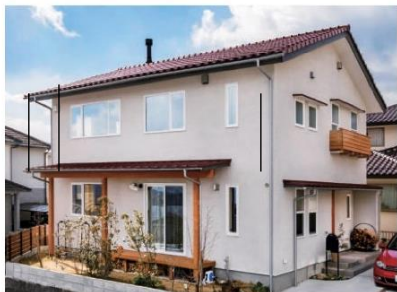
施工/永本建設株式会社
