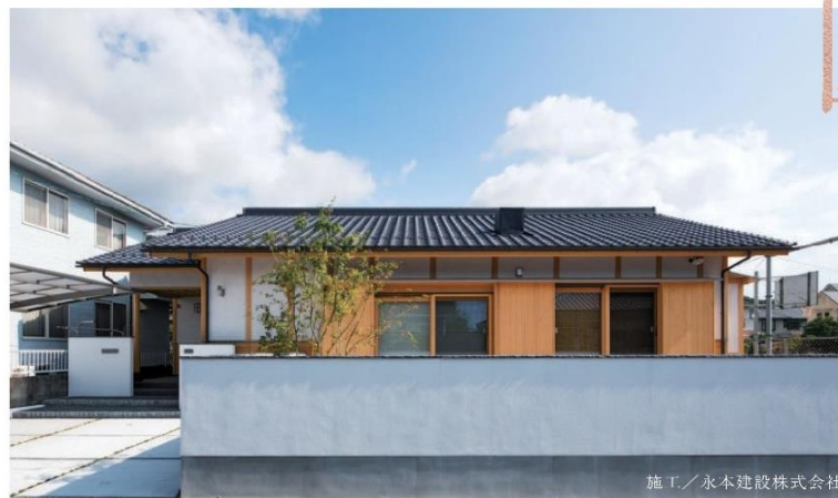
施工/永本建設株式会社
