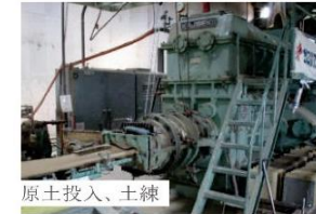
原土投入、土練
