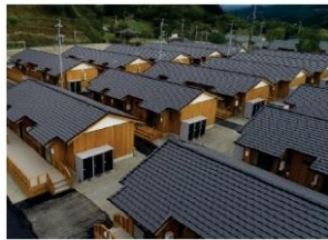
石州瓦が採用された熊本県の応急仮設住宅 画像提供/株式会社エアーフィールド
