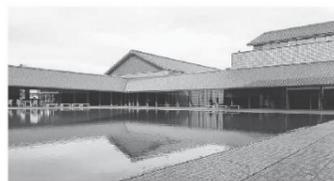
屋根瓦12万枚、壁瓦16万枚を使用。全国で初めて大型の壁に石州瓦を使用した建物で、石州瓦独特のガラス質の表面や赤茶の素材色が光の角度によっては金色に輝く
