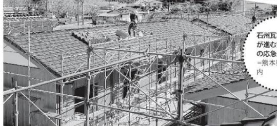
石州瓦での建設が進む熊本豪雨の応急仮設住宅=熊本県人吉市内
