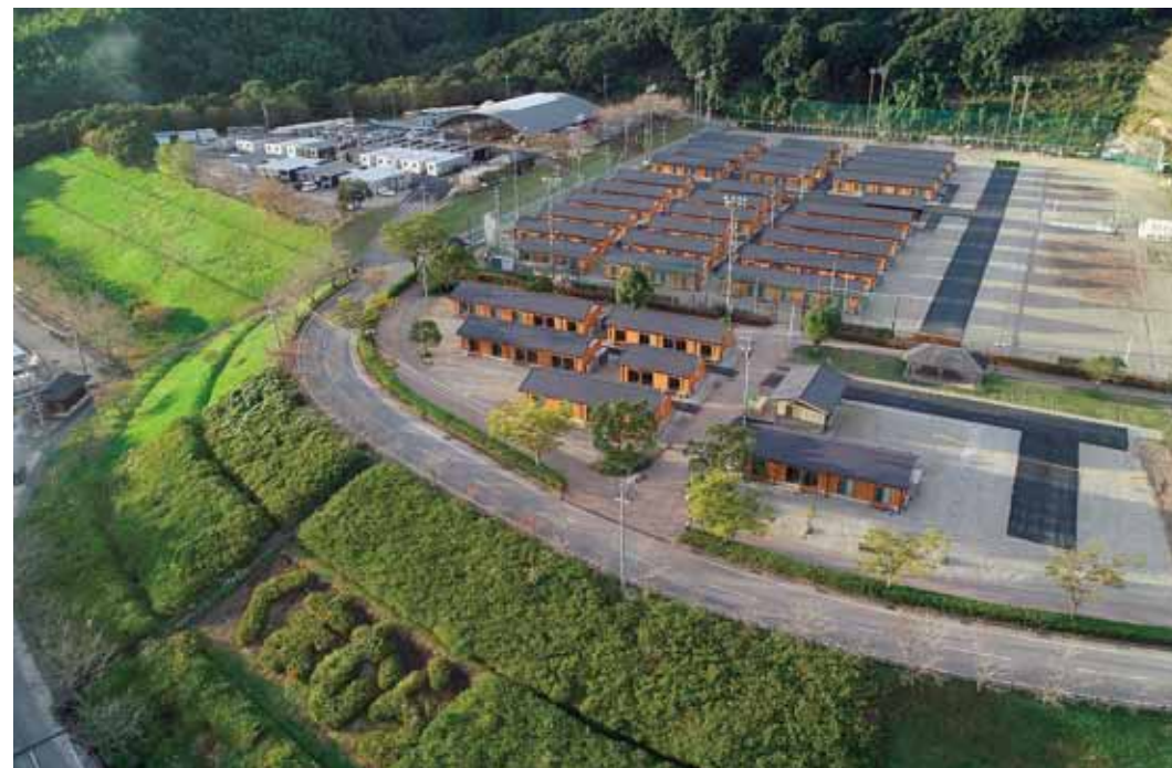
2020年10月7日に完成した球磨村グラウンド仮設団地
